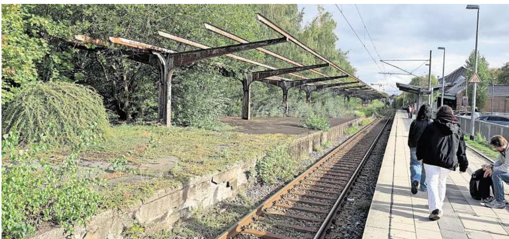
Der Hafenbahnhof Travemünde: Der heute genutzte Bahnsteig wurde 2004 gebaut. Der alte Bahnsteig links im Bild hatte damit ausgedient. Er verwildert. Fotos: Helge von Schwartz
