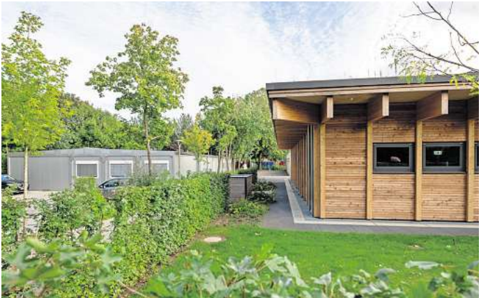
Die Grundschule Koggenweg in Buntekuh erhielt 2021 eine Containeranlage. Die Umsetzung eines geplanten Neubaus zieht sich hin.
