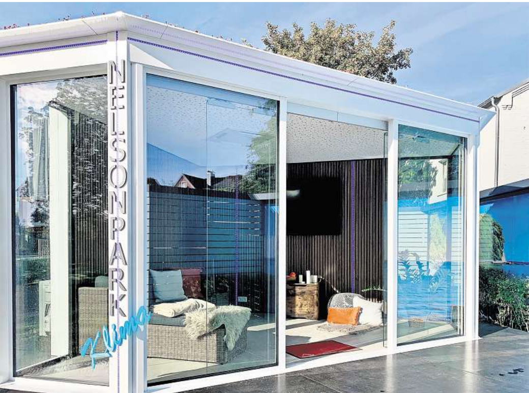
Ein geschützter Platz auf der Terrasse: Die neueste Innovation aus dem Hause Nelson Park Terrassendächer ist eine Dachbegrünung auf dem Wintergarten.
