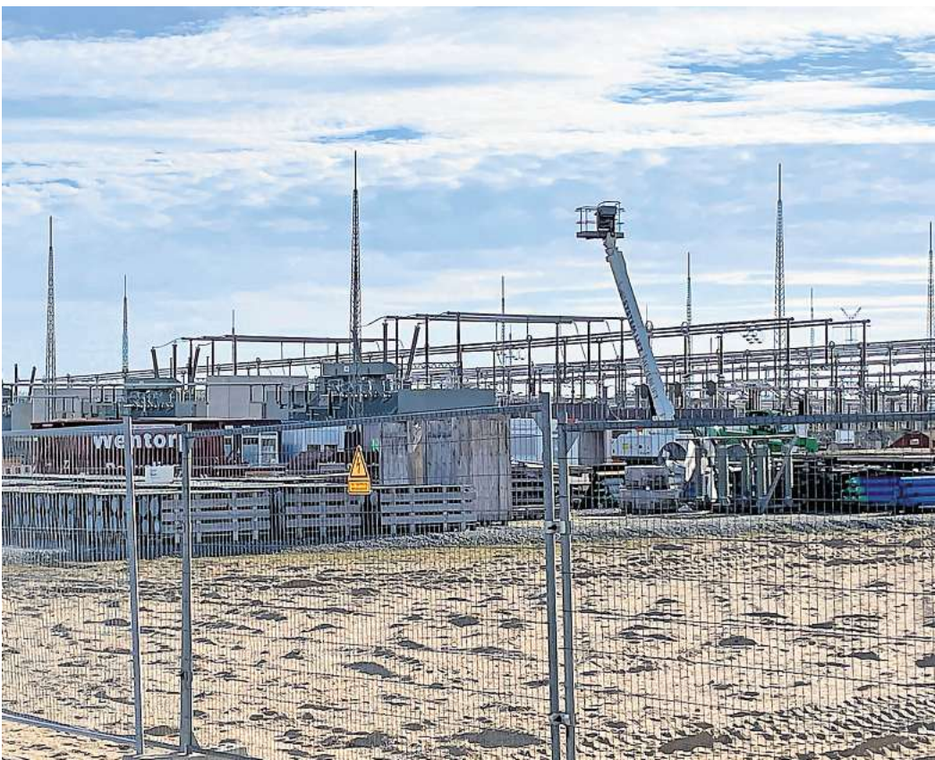
Das Umspannwerk Lübeck-West entsteht unweit zur Stockelsdorfer Dorfschaft Pohnsdorf an der L184.
