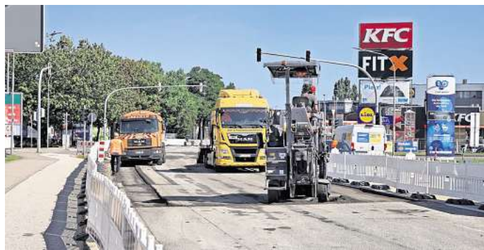
Der Reparatur-Abschnitt beginnt beim Schnellrestaurant KFC und endet am Kreisverkehr Lohmühlenteller.
