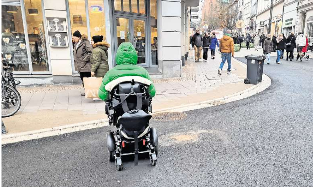
Der durchgängige, drei Zentimeter hohe Bordstein an der Ecke Beckergrube/Breite Straße kann für Rollstuhlfahrer zum Hindernis werden.
