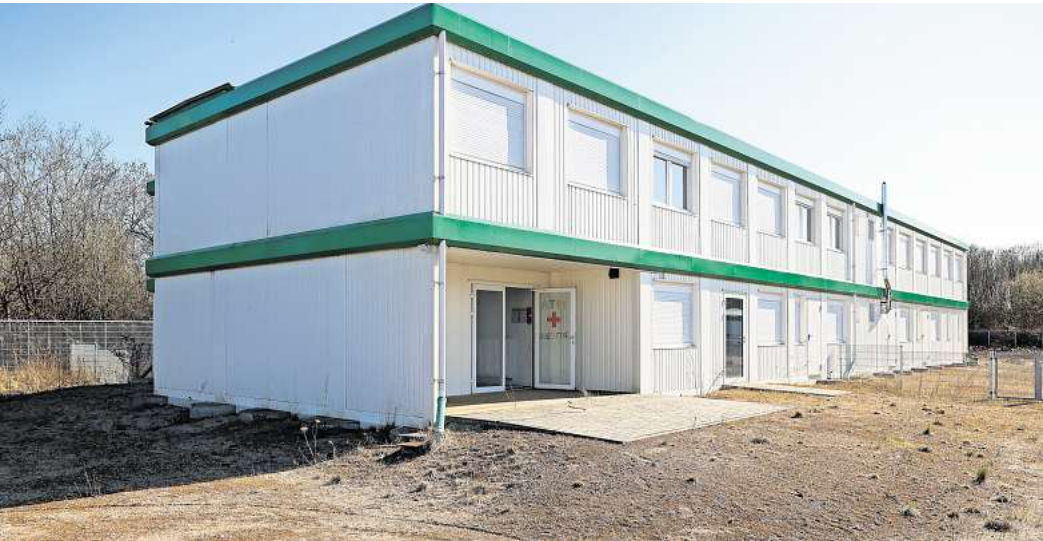
Mit dieser Containeranlage, die die Hansestadt vom DRK Lübeck gekauft hat, werden zusätzliche Räume für die Schule Grönauer Baum geschaffen.
