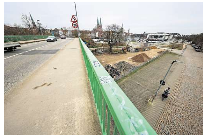
An der Marienbrücke sind von jetzt an bis voraussichtlich zum 2. September Reparaturarbeiten geplant. Archivfoto: Lutz Roessler
