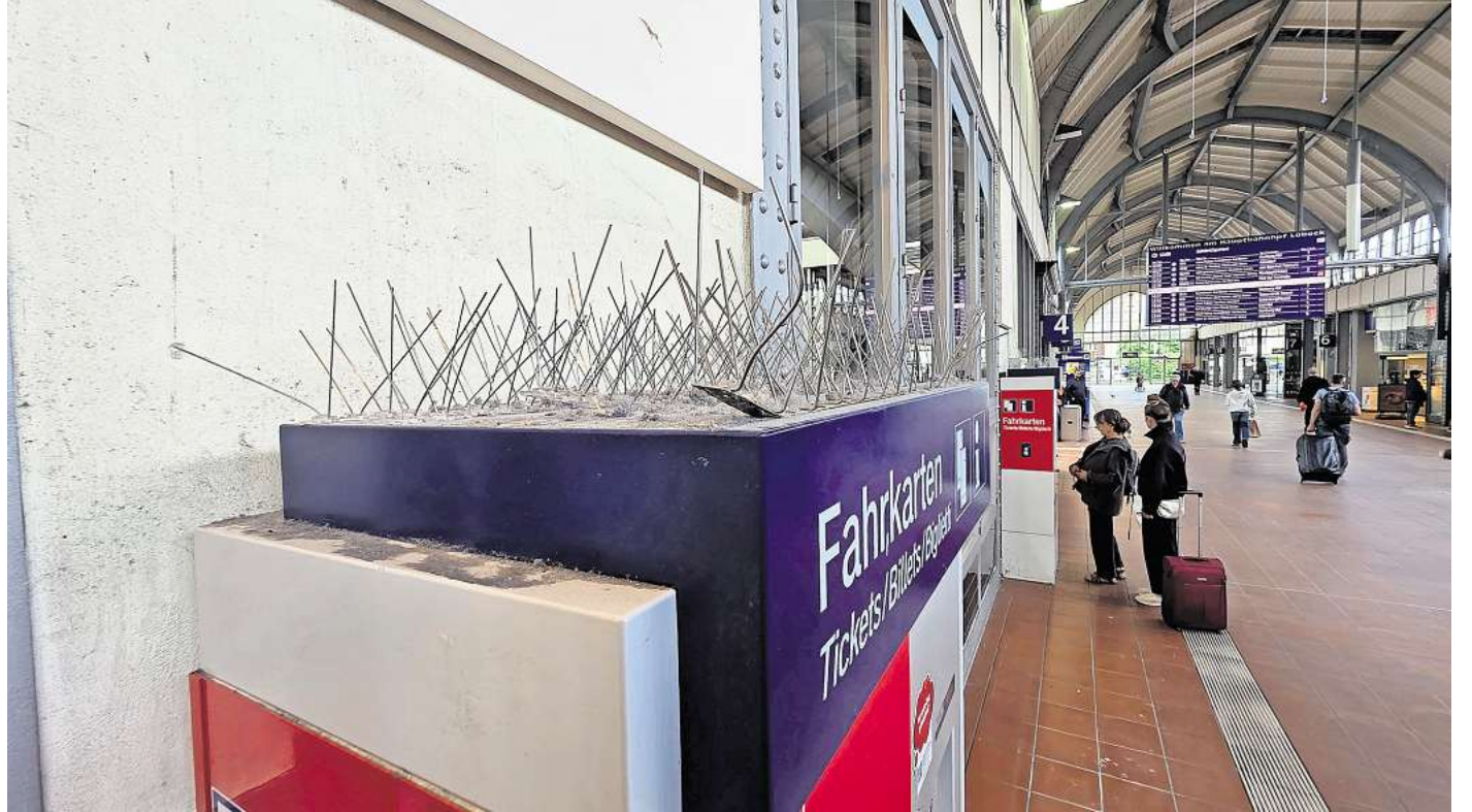
Diese Metallspikes sollen Tauben am Landen hindern – und werden oft zur Todesfalle.
