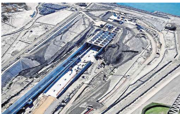
Der Bau des dänischen Portals zum Tunnel konnte 2025 weitgehend abgeschlossen werden. Die Arbeiten verzögern sich dennoch um Jahre. Foto: Femern A/S
