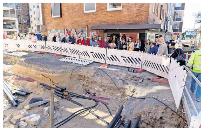
Die Stadtverwaltung lädt immer wieder einmal, wie hier Mitte Mai, zu Baustellenbesichtigungen in der Beckergrube ein. Die Baumaßnahme wird deutlich teurer als kalkuliert. Foto: Lutz Roeßler
