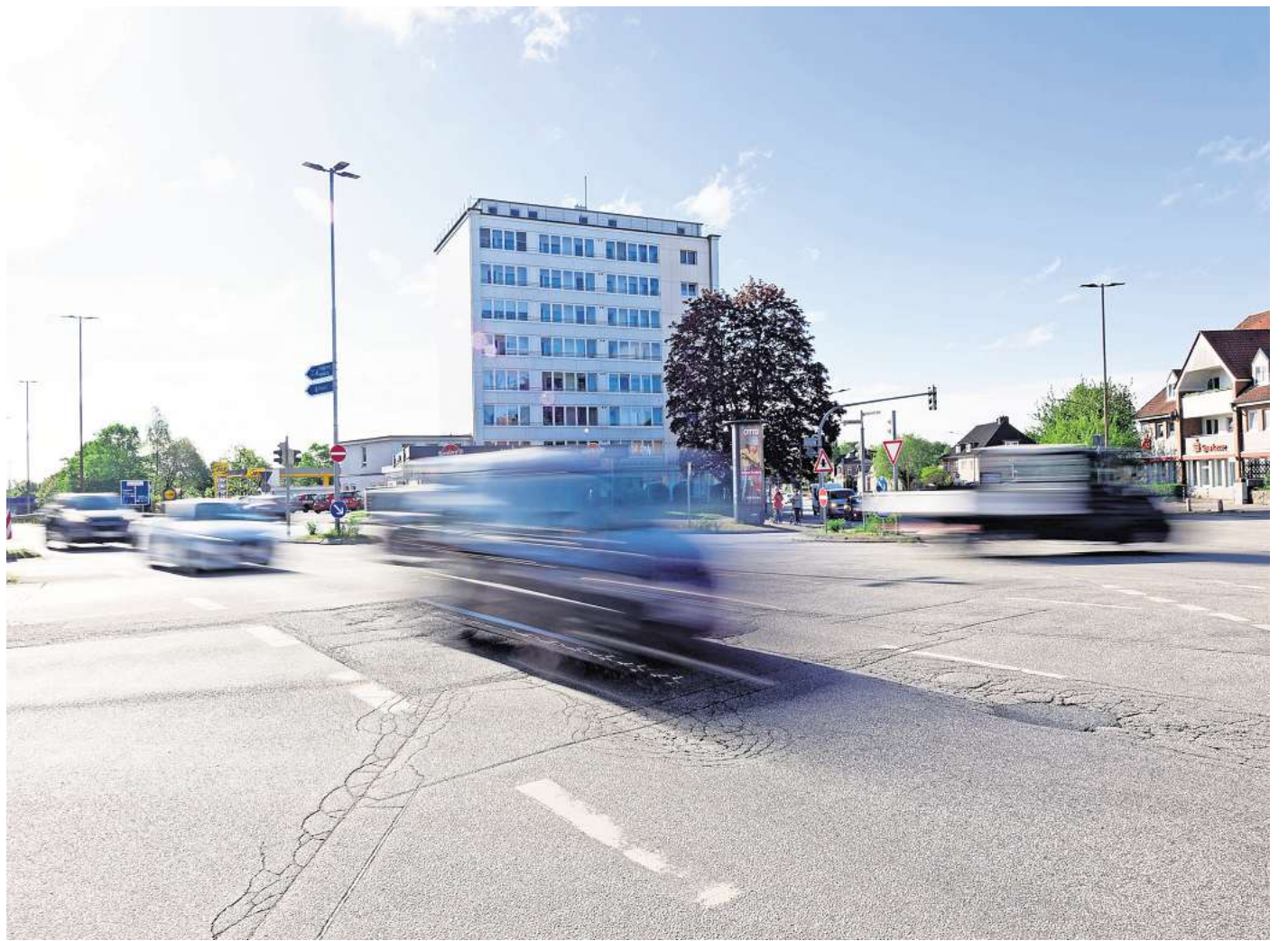
Der Knotenpunkt Krempelsdorfer Allee/Stockelsdorfer Straße/Friedhofsallee soll eine neue Fahrbahndecke bekommen. Fotos: Lutz Roeßler
