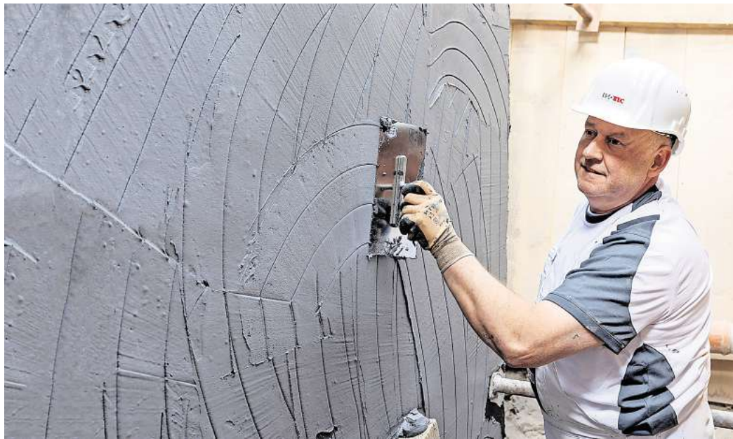
Bei einer Außenabdichtung werden mehrere Schichten auf dem Mauerwerk aufgetragen.
