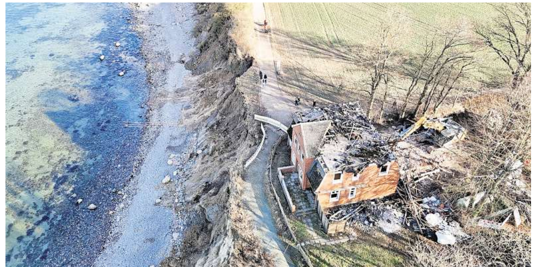
Ende des Denkmals am Brodtener Ufer: Am Nachmittag arbeitet sich der Bagger am Hauptgebäude von Haus Seeblick ab.
