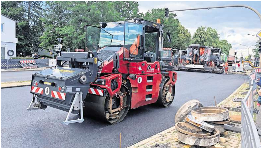
Von Mai bis September sollen in Lübeck voraussichtlich 37 Straßen per DSK-Verfahren saniert werden. Der Asphalt für DSK besteht aus einem Gemisch aus groben und feinen Gesteinskörnungen, Bitumenemulsion, Zusätzen und Wasser. Foto: Hansestadt Lübeck
