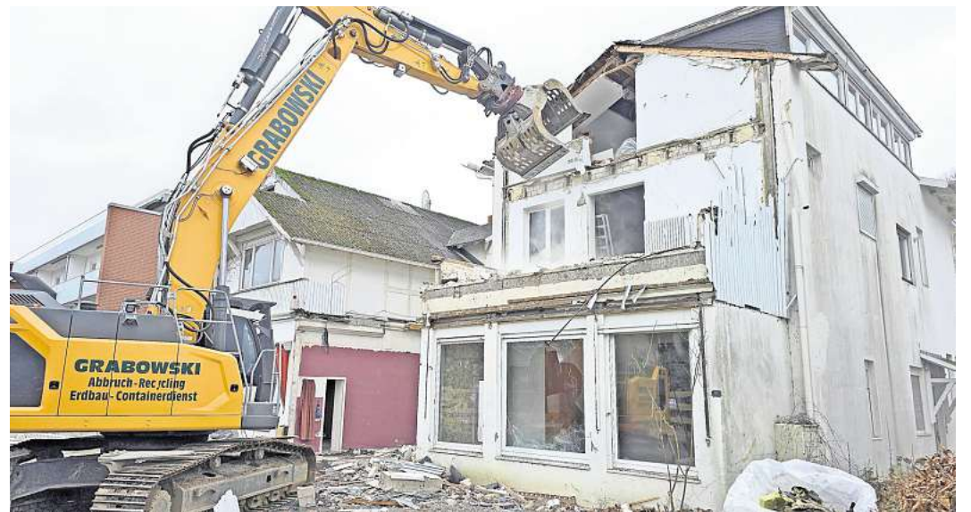
Der Abrissbagger hat zugepackt: In der Kaiserallee wird eines der Gebäude abgerissen, die über Jahrzehnte das Hotel Seegarten beherbergten. Foto: Holger Kröger
