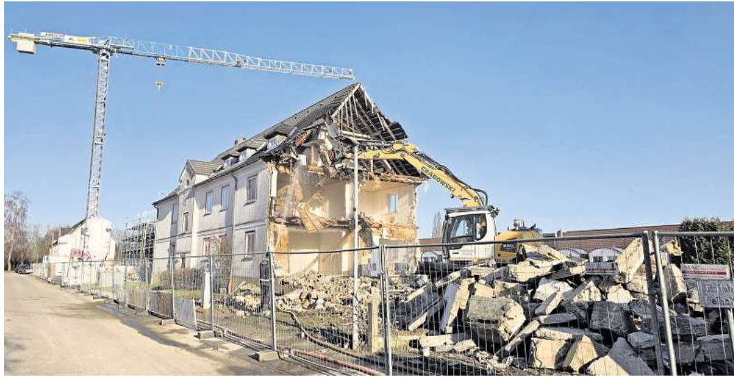
In der Guldernen Straße in Kücknitz werden derzeit Wohnblocks abgerissen. Dort lässt der Lübecker Bauverein neue Gebäude errichten. Foto: Holger Kröger
