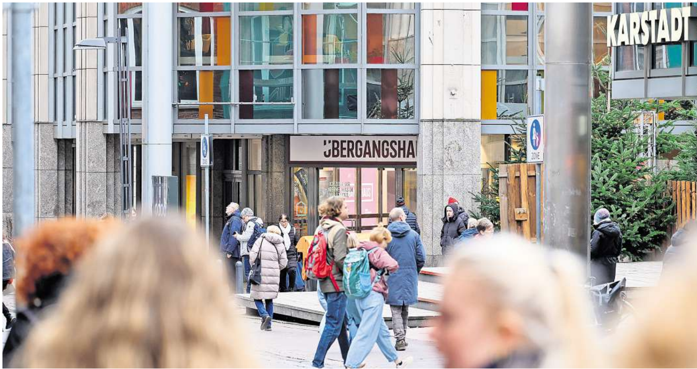
Das Übergangshaus wird bald zur Baustelle.
