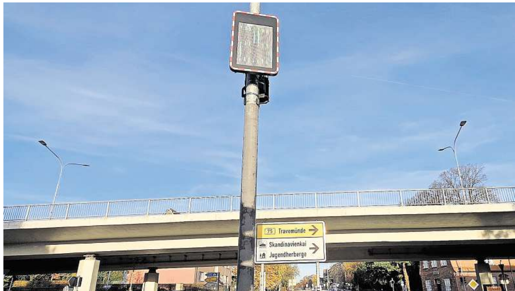
Die Hansestadt Lübeck hat in den vergangenen Wochen an mehreren Standorten neue Tempoanzeigen installiert – unter anderem an der Kreuzung St. Jürgen-Ring/Ratzeburger Allee. Foto: Holger Kröger
