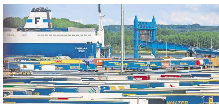
Die Hafenbehörde LPA verwaltet die Hafenanlagen wie hier den Skandinavienkai in Travemünde.
