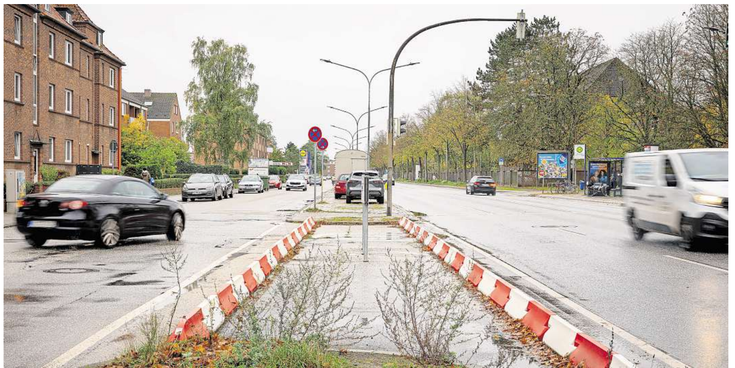
Von der Oderstraße aus gelangen Verkehrsteilnehmer nicht mehr auf die Schwartauer Landstraße. Die Zufahrt ist baulich blockiert. Foto: Agentur 54°
