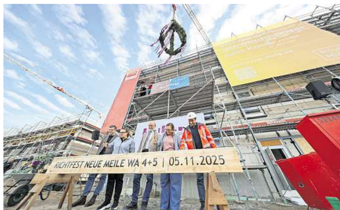
Vertreter des Bauherren Wohnkompanie Nord und des Generalunternehmers Köster Bau feierten Richtfest auf der Neuen Meile in Lübeck. Foto: Lutz Roeßler
