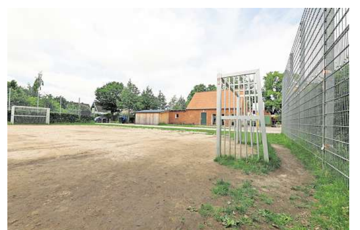
Schon 2017 forderte der Schulverein die Sanierung des Bolzplatzes Groß Steinrade. Acht Jahre später ist es so weit. Foto: Lutz Roeßler
