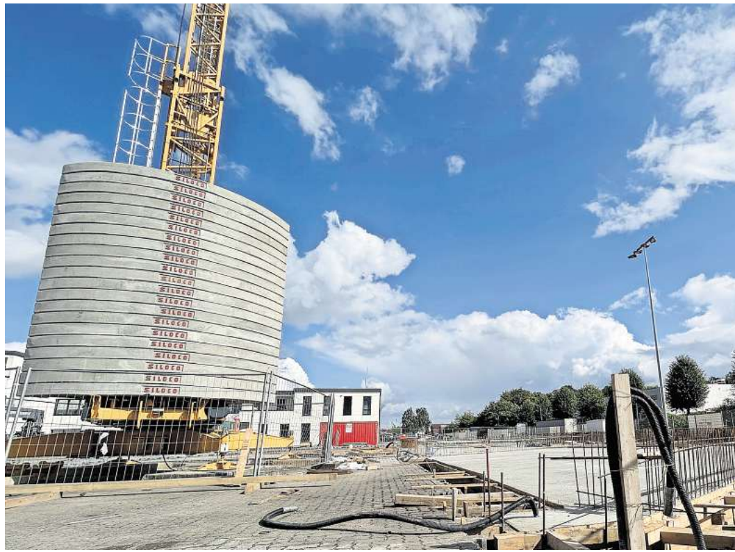
Im Gewerbegebiet Roggenhorst entsteht Lübecks erste Wasserstofftankstelle. Die Bauarbeiten haben im August begonnen. Foto: Jana Kubasch
