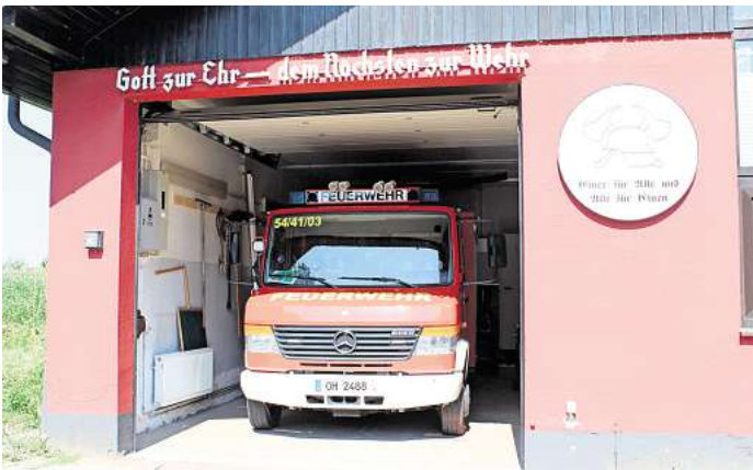
Die kleine Halle im Gebäude der Ortsfeuerwehr Griebel-Vinzier hat nur Platz für ein älteres, modernisiertes Fahrzeug. Neufahrzeuge könnten dort nicht untergestellt werden.
