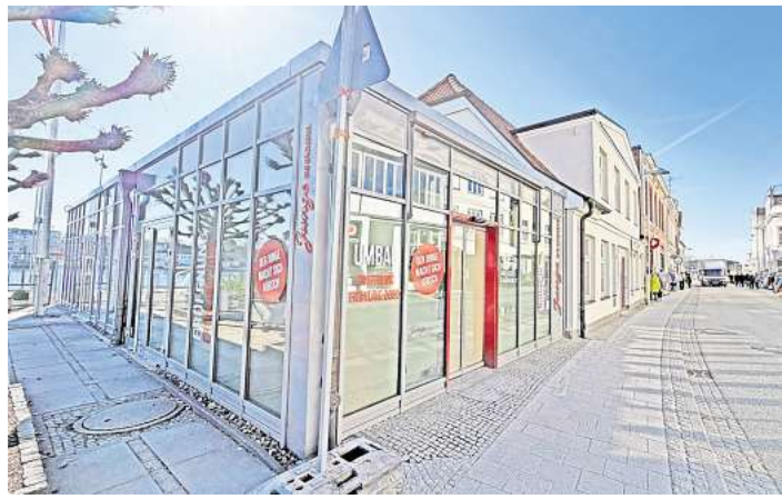
Die Filiale der Bäckerei Junge in der Vorderreihe wird derzeit saniert. Doch die Eröffnung verzögert sich. Foto: Thomas Krohn
