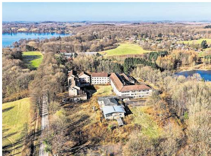
Still ruhen die Seen. Anstelle der leerstehenden Kurklinik am Hängebergshorst in Malente-Krummsee soll ein nobles Spa-Hotel mit dem Arbeitstitel Lakeside Resort entstehen. Foto: Dirk Schneider
