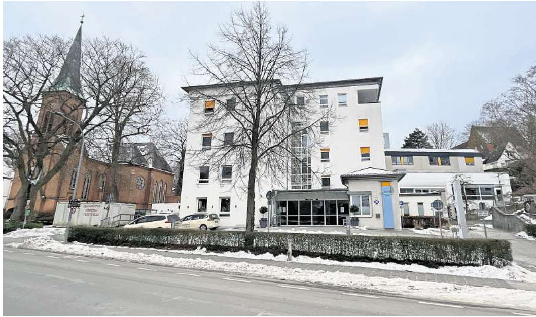
Bis auf eine Station ist das Altgebäude mit angefügten Flügeln an der Plöner Straße leer, erste Sanierungs- und Modernisierungsarbeiten sind bereits angelaufen. Fotos: Ulrike Benthien
