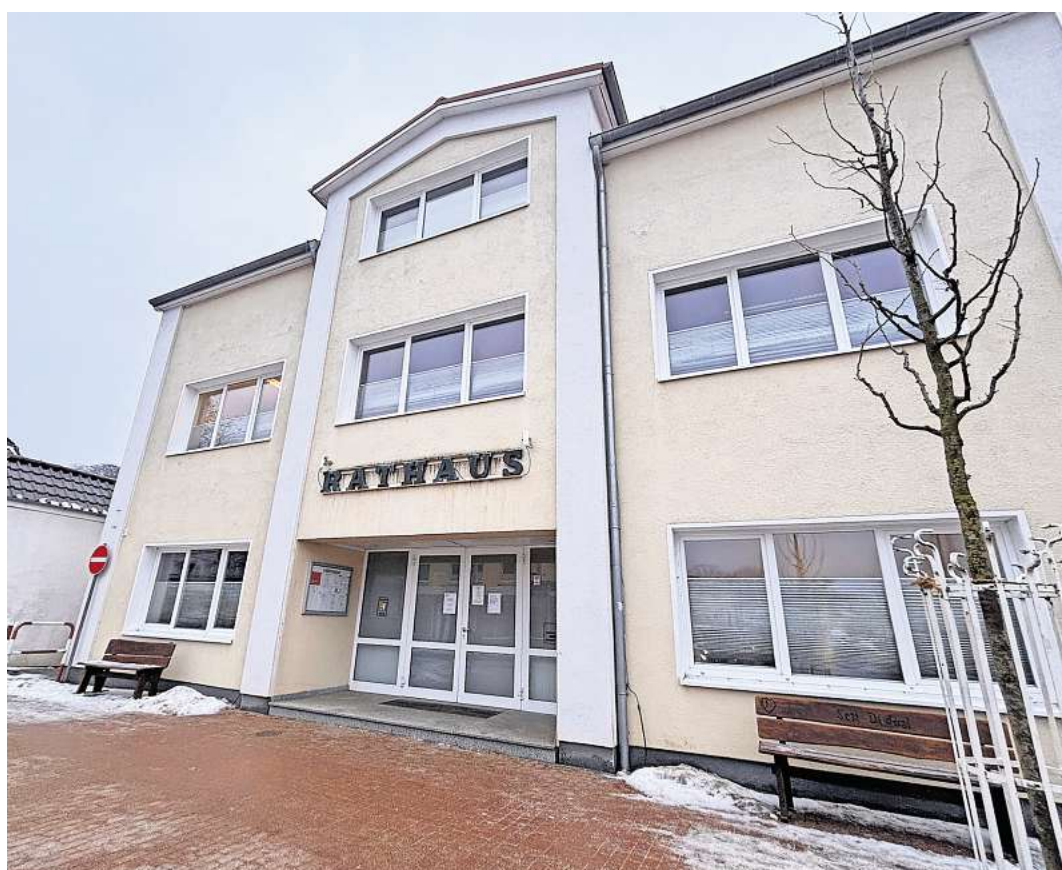
In der kommenden Zeit kann es aufgrund von Wiederherstellungsarbeiten immer mal wieder zu Einschränkungen im Rathaus-Betrieb kommen. Foto: Maika Wegner
