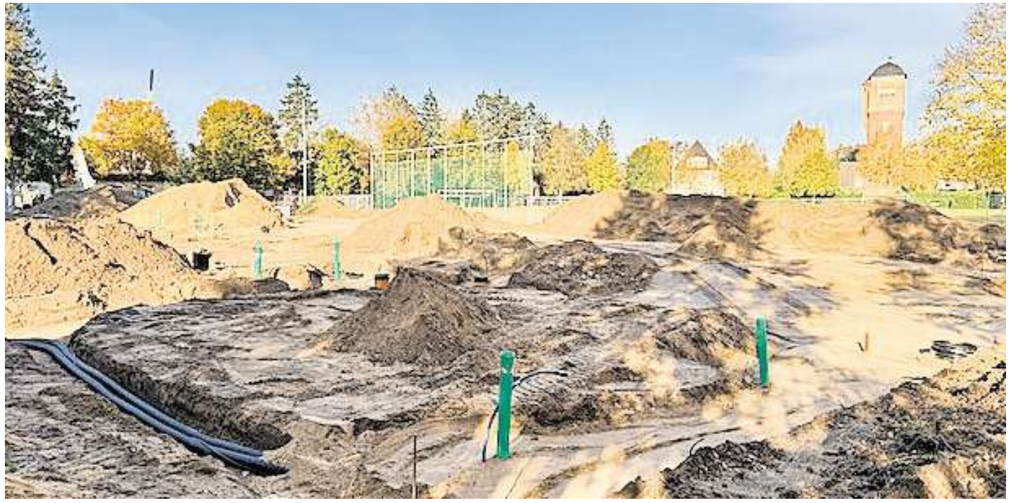
Nach dem Abriss der Sporthalle in der Ringstraße wird derzeit der Bauplatz für ein Containerdorf mit Flüchtlingsunterkünften vorbereitet. Foto: Dirk Schneider
