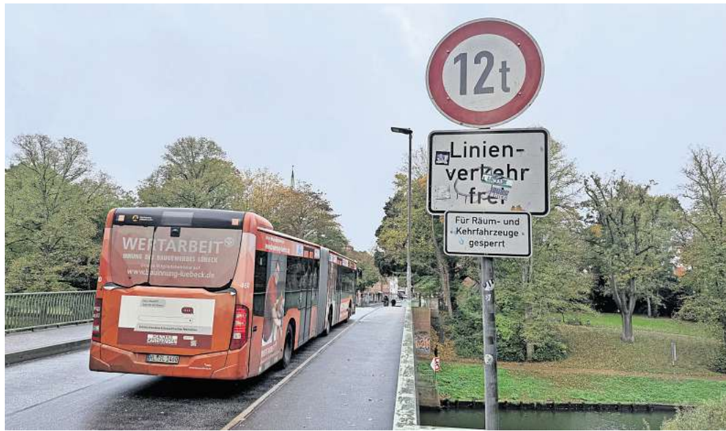
Linienbusse wiegen meist deutlich mehr als zwölf Tonnen. Doch für sie gilt auf der Rehderbrücke eine Ausnahme.
