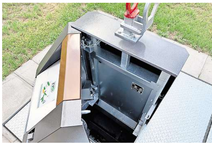
Nach dem Öffnen der Servicetür kann man in den Unterflurbehälter der Müllsammelstelle schauen.
