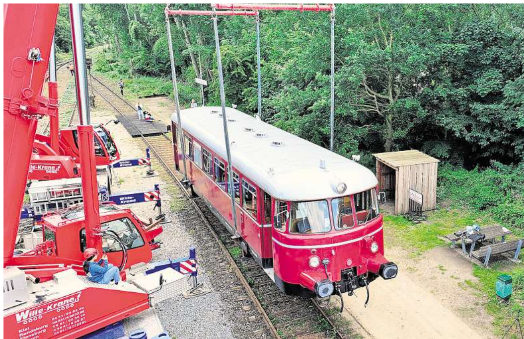
Der 20 Tonnen schwere Schienenbus wird mit zwei Schwerlastkränen ins Gleis gehoben. Foto: Sylvia & Mathias Pank
