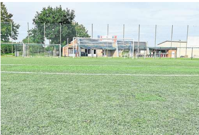
Der Kunstrasenplatz in Gleschendorf weist inzwischen viele Schäden auf, die stellenweise notdürftig geflickt wurden. Zudem lösen sich die Fasern vom Gewebe ab. Jetzt soll ein neuer Belag verlegt werden, entschied die Gemeindevertretung Scharbeutz. Foto: Beke Zill
