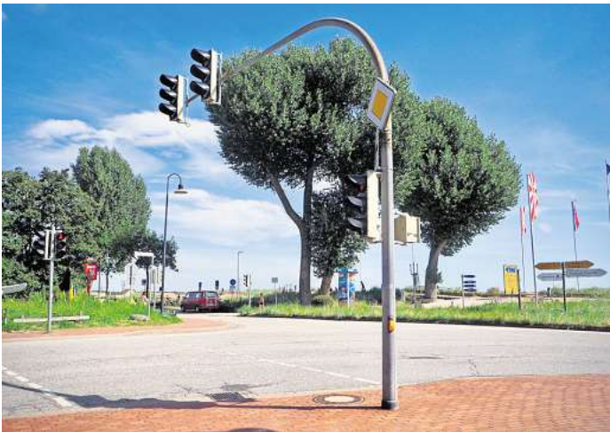
An der Kreuzung Pönitzer Chaussee/Strandallee beginnen die Baumaßnahmen.
