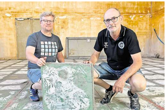
Der gesamte Boden der kleinen Halle muss raus, jede der schweren Platten wird einzeln abtransportiert. Jan Nellies (li.) und Rüdiger Jürs vom TSV Pansdorf begutachten den Stand der Arbeiten. Fotos: Sabine Jung
