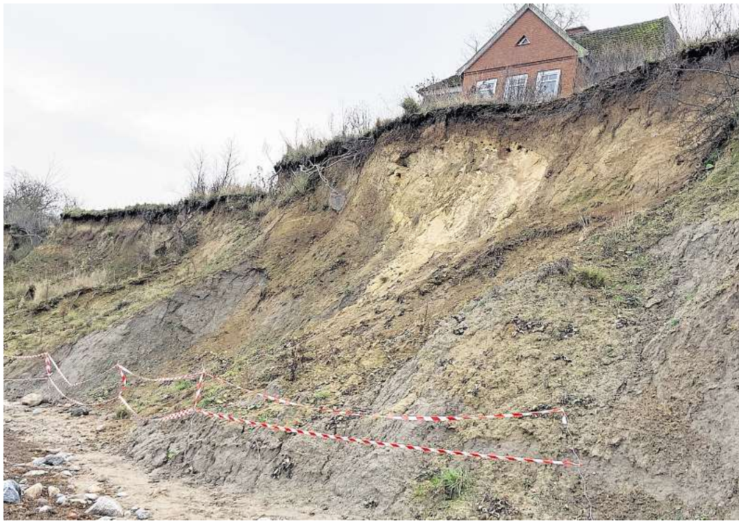
Unterhalb von Haus Seeblick ist am Steiluferfuß inzwischen rot-weißes Flatterband gespannt worden. Foto: Michael Hollinde
