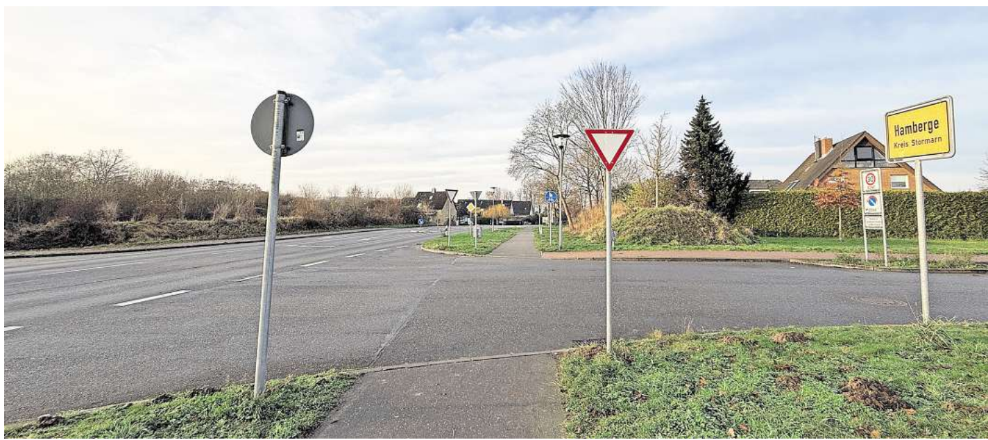
Am 4. Mai 2026 geht's los. Dann startet die Sanierung der B75 ab Haferkoppel. Die Straße wird komplett gesperrt.
