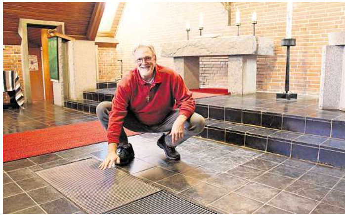
Pastor Rüdiger Fuchs fühlt, ob die elektrische Heizung der Dahmer Geroldskapelle in Gang kommt. Foto: Markus Billhardt
