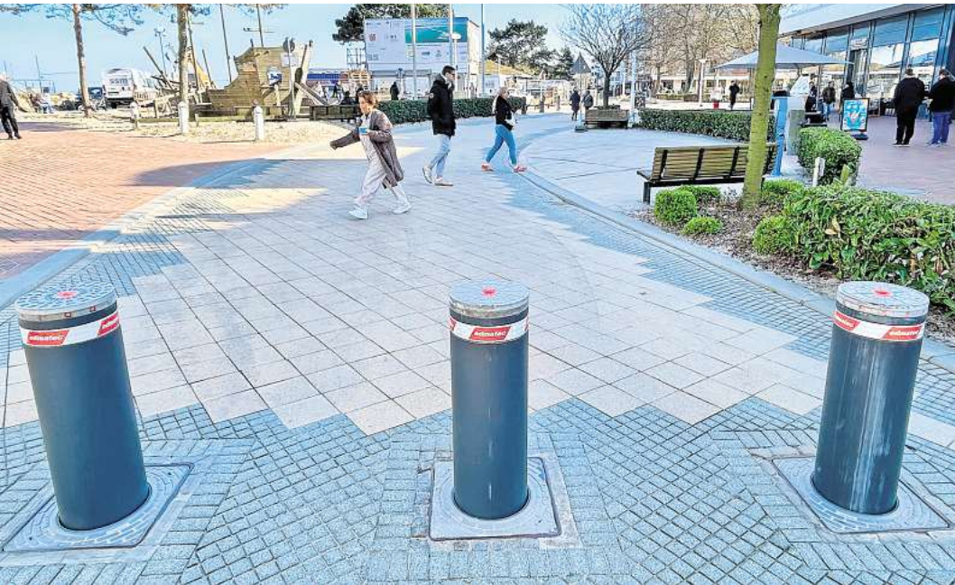
Diese Hydraulikpoller machen von April bis Ende Oktober die Strandallee in Scharbeutz zur Fußgängerzone.
