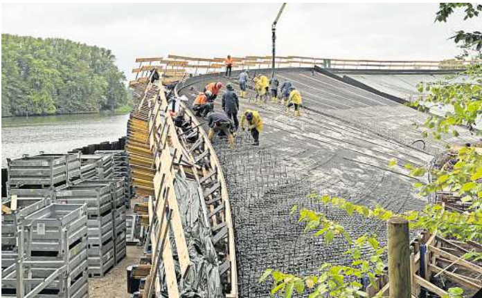
Die Arbeiter gießen mithilfe der Betonpumpe den flüssigen Beton in die Tribünenschale. Foto: Beke Zill
