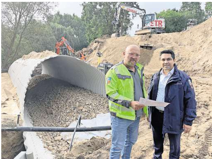
Baustellen-Inspektion am Bauplatz für die neue Brücke zwischen Sereetz und Bad Schwartau: Andreas Hachmeister (li.) und Bauamtsleiter Akbar Nassery überprüfen den Bauzeitplan.
