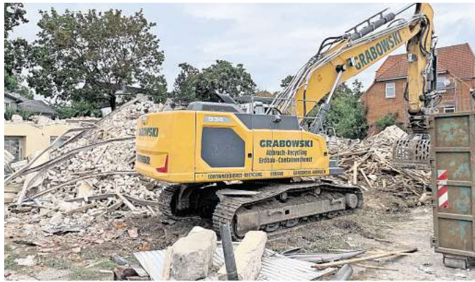
Die Firma Grabowski hat mit dem Abbruch an der Mühlenstraße in Bad Schwartau begonnen. Auf dem Areal plant der Lübecker Bauverein ein Neubauprojekt.
