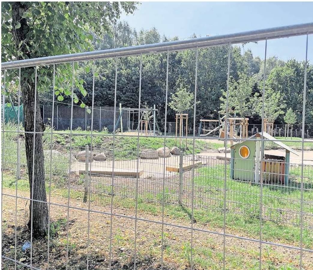
Zutritt verboten – ein Bauzaun versperrt den Weg zum neuen Spielplatz an der Max-Hamerich-Straße in Stockelsdorf.
