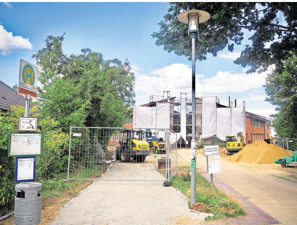
Nach den Sommerferien verläuft der sichere Zuweg für die Schulkinder jetzt links am Schulgebäude vorbei zum Pausenhof, daneben – mit Absperrung dazwischen – fahren dann die Baustellenfahrzeuge entlang.
