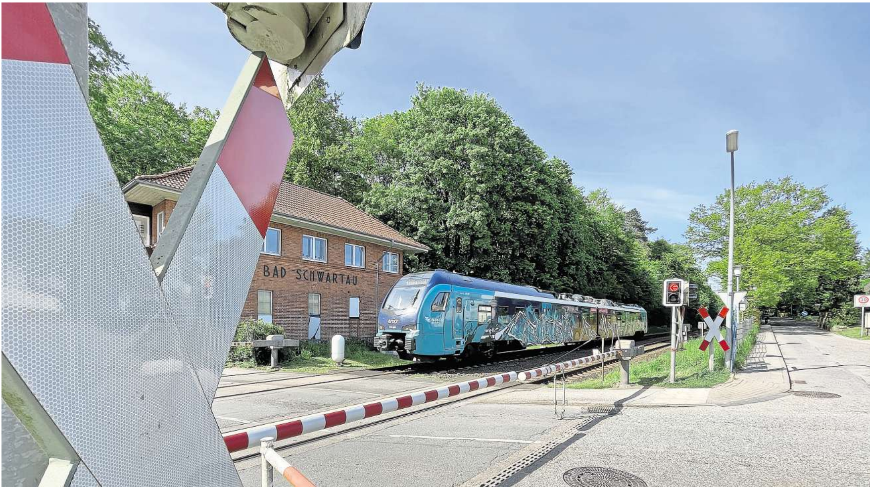
Der Bahnübergang kommt weg: Wenn die Bestandstrasse durch Bad Schwartau ausgebaut wird, soll eine Brücke in der Kaltenhöfer Straße über die Gleise führen. Foto: Manuel Büchner
