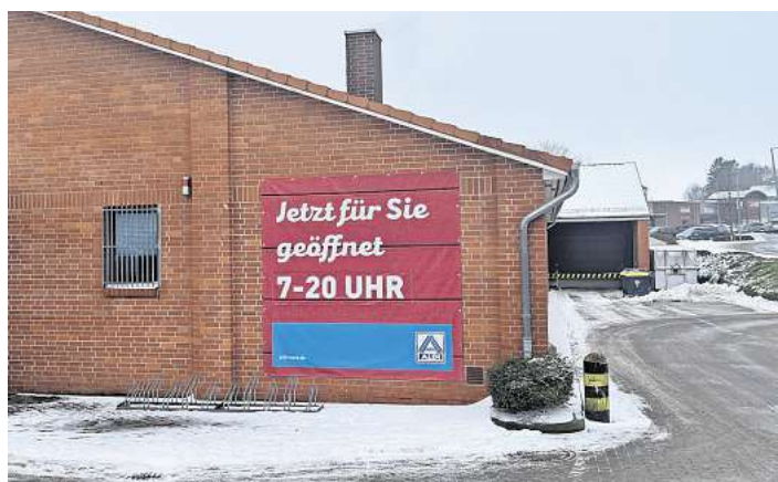
Der Aldi-Markt in Ahrensböck, der an Rossmann und Rewe (im Hintergrund) grenzt, soll noch in diesem Jahr abgerissen und neu gebaut werden. Foto: Beke Zill
