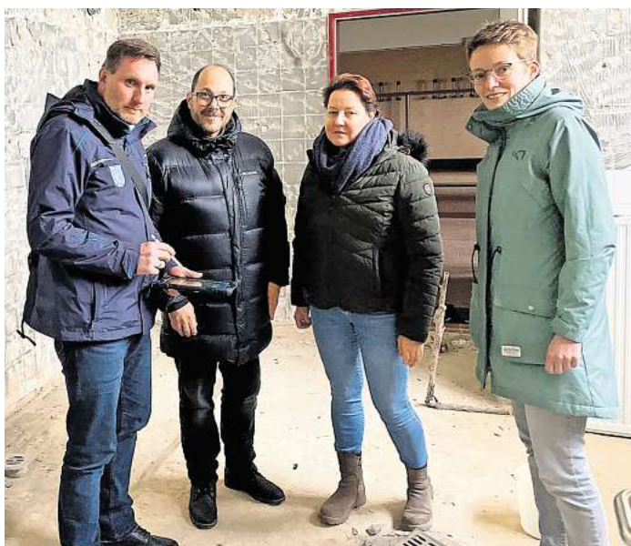
Baubesprechung im Sportzentrum Jahnstraße in Stockelsdorf: Bautechniker Dirk Schmidt (v.li.), Bauamtsleiter Jan-Christian Ohm, Marion André aus dem Bereich Bauunterhaltung und die ATSV-Vereinsmanagerin Saskia Fischer.
