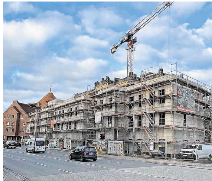
Direkt an der Ortsgrenze zu Lübeck wächst der Neubau mit 48 Wohneinheiten.
