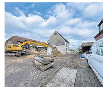
Abbrucharbeiten in Stockelsdorf. Die Firma Grabowski trägt die alten Bestandsgebäude an der Ahrensböcker Straße (unweit der Villa Jelsen) ab. I Foto: Sebastian Frey
