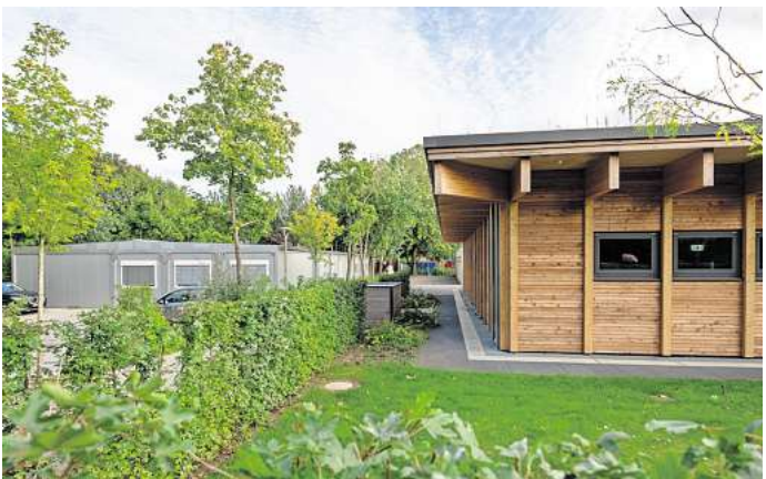
Die Grundschule Koggenweg in Buntekuh erhielt 2021 eine Containeranlage. Die Umsetzung eines geplanten Neubaus zieht sich hin.
