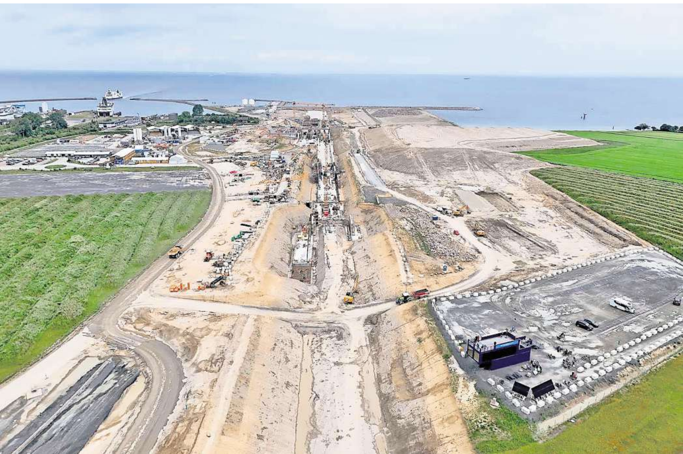
Riesige Ausmaße: die deutsche Baustelle des Fehmarnbelttunnels im Norden Fehmarns. Rechts im Vordergrund ist die Beltbox zu sehen – eine Aussichtsplattform mit Blick auf das Baugeschehen.
